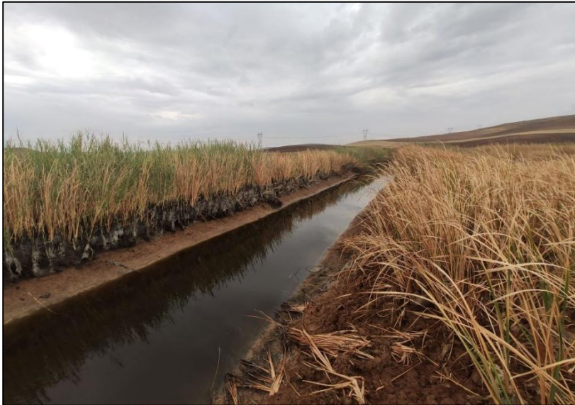
Şekil 22. Tatlıcak Göletindeki drenaj kanallarının görüntüsü (01.10.2023).
