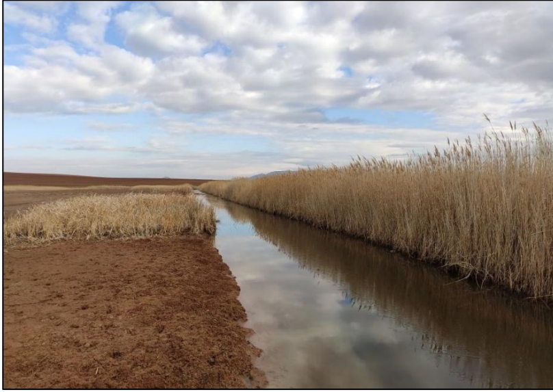
Şekil 23. Tatlıcak Göletindeki drenaj kanallarının görüntüsü (04.01.2025).
