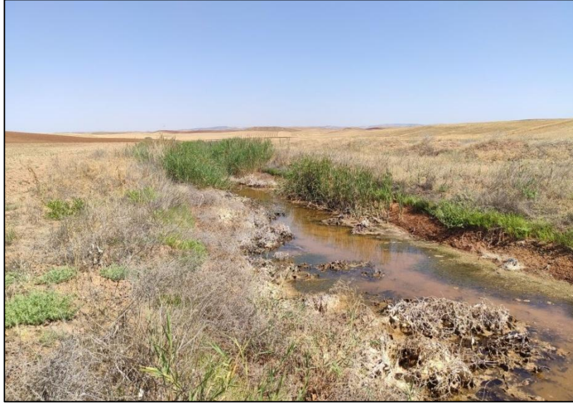
Şekil 21. Tatlıcak Göletindeki drenaj kanallarının görüntüsü (03.08.2023).
